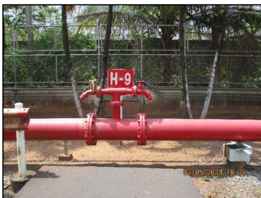
ภาพถ่ายที่ 2.2-27 ระบบจ่ายน้ำดับเพลิง
