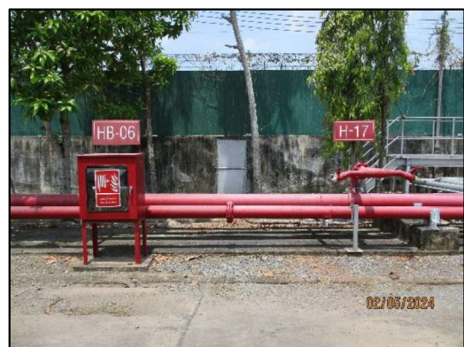
ภาพถ่ายที่ 2.2-25 ระบบท่อน้ำดับเพลิง และสายฉีดน้ำดับเพลิง
